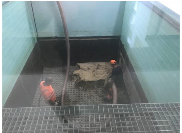
Figure 3.2 Vidange du média aspiré par le camion hydrocureur vers la benne de stockage temporaire.
