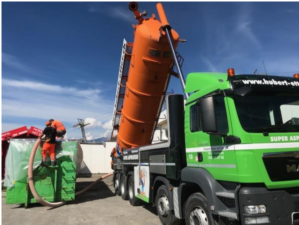
Figure 3.2 Vidange du média aspiré par le camion hydrocureur vers la benne de stockage temporaire.
