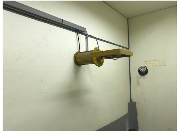
Figure 3.11 Clapet des eaux sales coté filtre et vérin de commande du clapet des eaux sales
