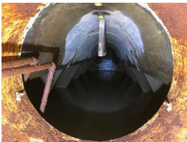
Figure 3.7 Système de distribution sous le plancher du filtre de reminéralisation et lame déversante
