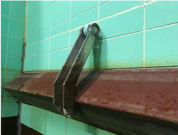
Figure 3.11 Clapet des eaux sales coté filtre et vérin de commande du clapet des eaux sales
