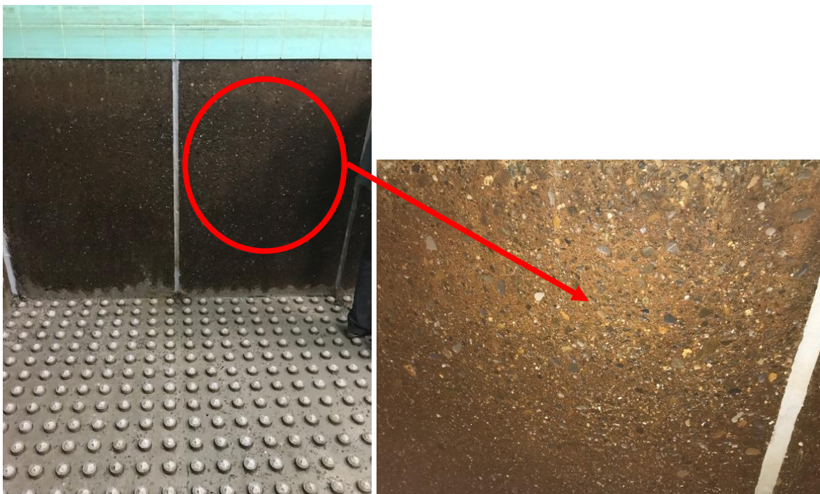
Figure 3.5 Voiles périphériques du filtre de reminéralisation
