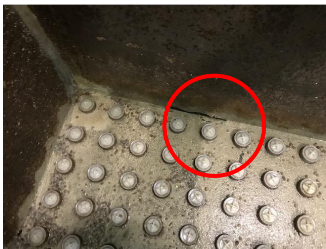
Figure 3.6 Joint entre le voile périphérique et le plancher
