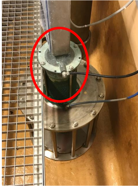
Figure 3.9 Vanne alimentation du filtre de reminéralisation
