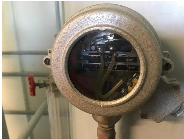
Figure 3.12 Ancien capteur contenant du Mercure
