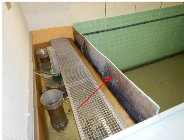
Figure 3.7 Système de distribution sous le plancher du filtre de reminéralisation et lame déversante
