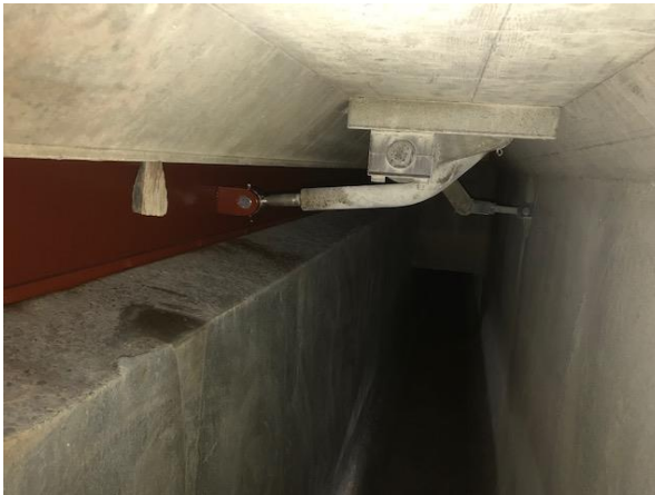
Figure 3.10 Clapet et système de manœuvre du clapet des eaux sales coté canal des eaux boueuses
